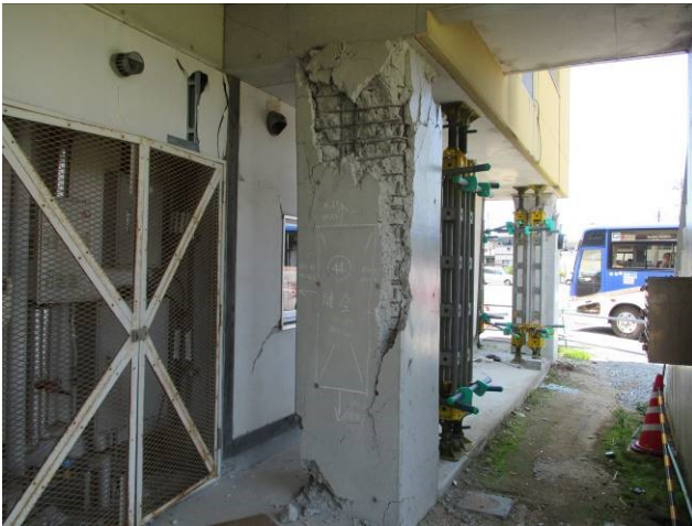
熊本県宇土市にあるマンションのピロティー被害 2019年（右写真）には被害を受けたピロティーの補修と耐震化がなされていた
