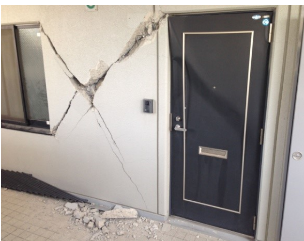
熊本市東区の被災したマンションでは雑壁が壊れたが、2年後に視察した際には雑壁を直し住まれ続けている
