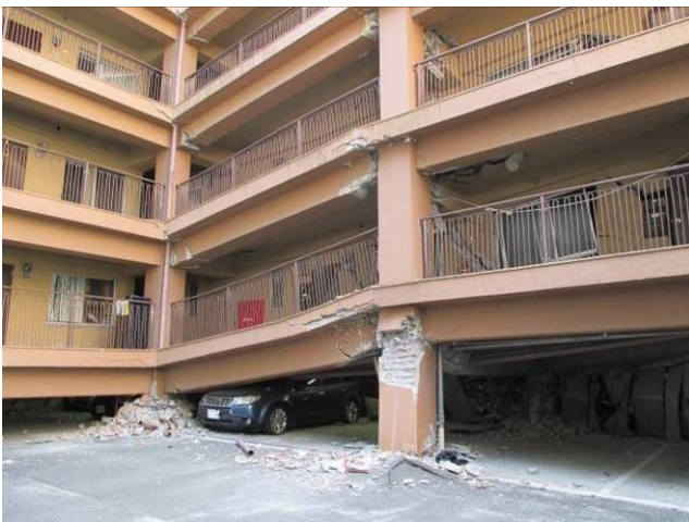
ピロティ被害の2事例。熊本市西区のマンション（左）と、熊本市東区のマンション（右）
