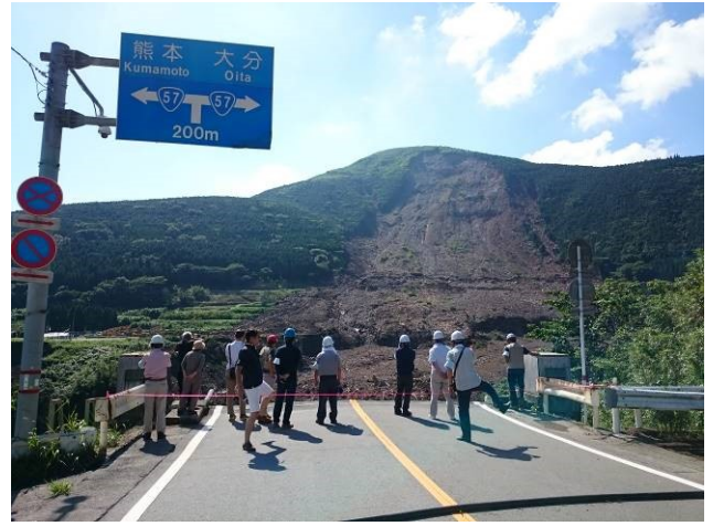
土砂崩れにより崩落した阿蘇大橋（第1次調査）
