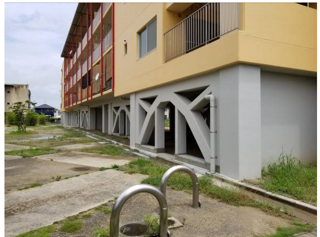
熊本県宇土市にあるマンションのピロティー被害 2019年（右写真）には被害を受けたピロティーの補修と耐震化がなされていた
