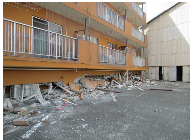
ピロティ被害の2事例。熊本市西区のマンション（左）と、熊本市東区のマンション（右）
