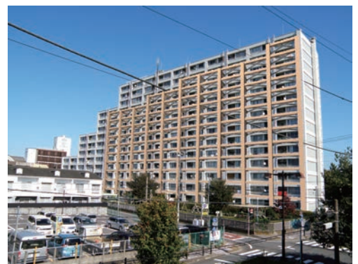
写真1 A案アウトフレーム (150 構面) ブレース無し ※管理組合採択案
