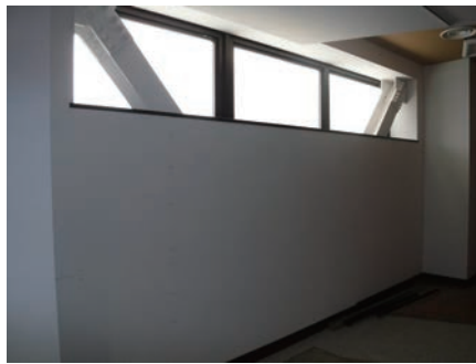
ブレースの前に内装壁を設けた箇所。上部は排煙窓
