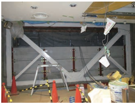
鉄骨ブレースの設置工事
