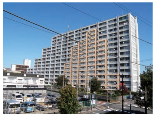
写真2 B案アウトフレーム (70 構面) ブレース付き
