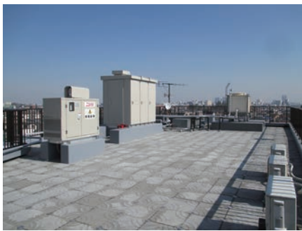
改修後の屋上
