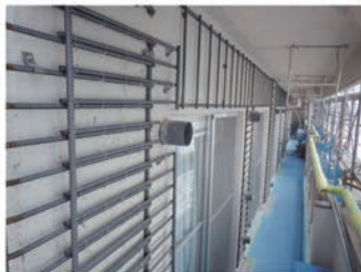
鉄筋パネル建て込み
