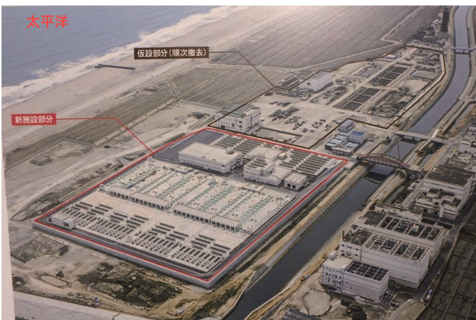
写真4 震災から5年を経て新しい施設が完成した
