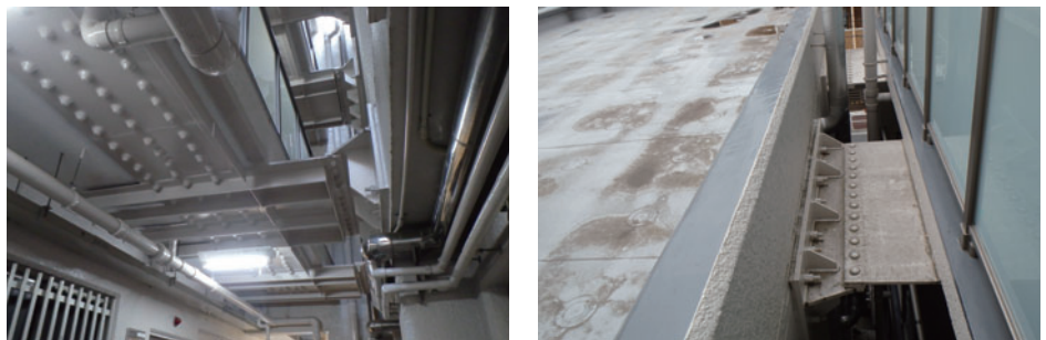
主棟と副棟をつなぐ鉄骨部材(右:上から見たところ、左:下から見たところ)
