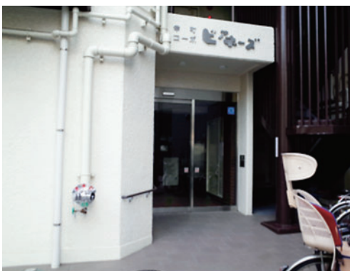
自動ドア化した正面玄関とスロープ
