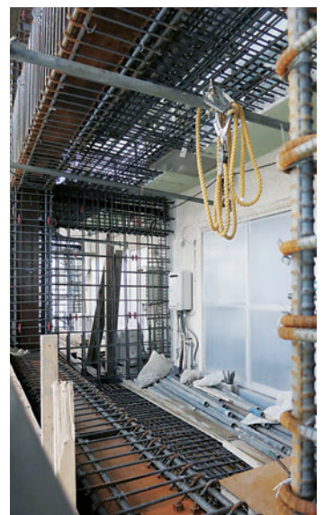
フレーム取付け工事
