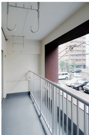
バルコニー工事完了
