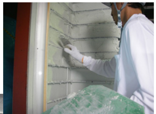
（右上・中下）サイド・ポ・スト工法：鉄筋を工場にて作成、現場設置後、特殊ポリマーセメントモルタルを左官にて2～3回、扱き塗り込む。
