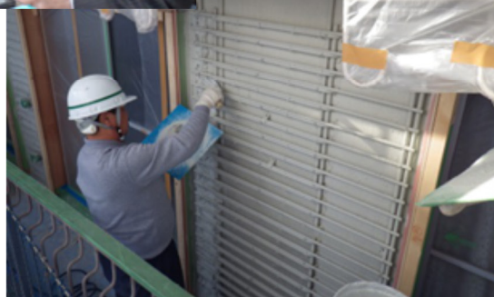
（右上・中下）サイド・ポ・スト工法：鉄筋を工場にて作成、現場設置後、特殊ポリマーセメントモルタルを左官にて2～3回、扱き塗り込む。
