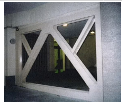
ブレースの補強
