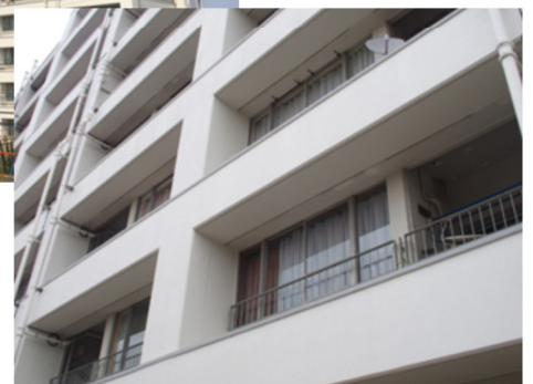
(左) 幸町コーポピアネーズ／外付けフレーム補強 (中・右下) 豊玉南住宅／直付けフレーム補強
