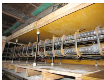
在来工法で1階から順次施工
