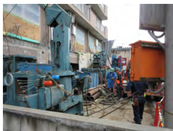
2階バルコニーを解体し杭工事
