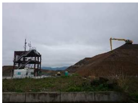
被災した南三陸防災対策庁舎 うす高く積まれた盛土
