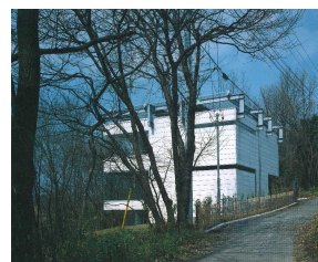
打ち放しを外断熱に改修
