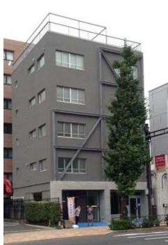
耐震補強 + 外断熱 + ペアガラスのサッシュへ改修(A D H)
