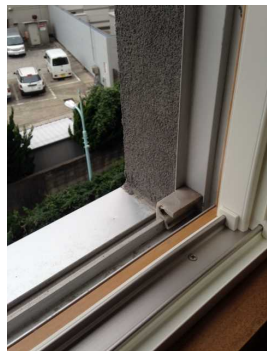
耐震補強 + 外断熱 + ペアガラスのサッシュへ改修(A D H)
