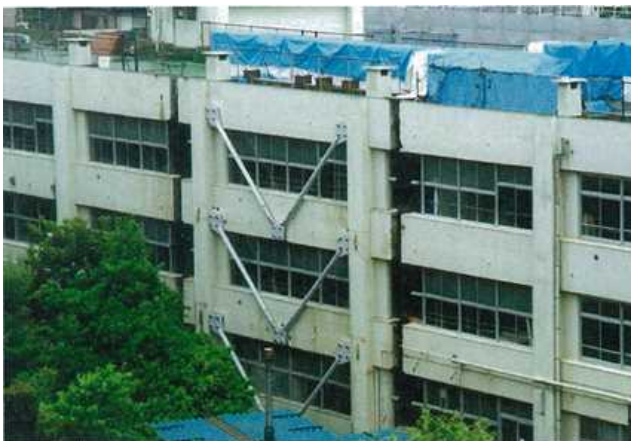
解体予定の小学校校舎の外壁に制震ブレースを取付け、仮動的実験を実施。結果、頂点変位の最大値は無補強時で68mm、補強時は32mmと半分以下に低減された。
