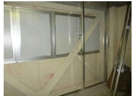
鉄骨ブレース新設
