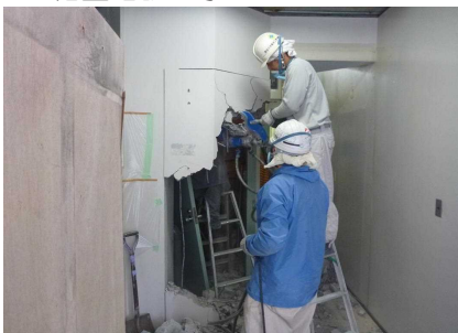
既存袖壁撤去
