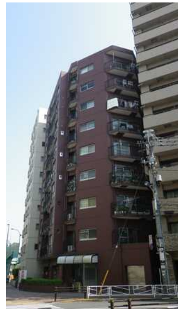
アワノ建築設計がある トーカンマンション王子 管理組合副理事長として発注者の立場で 耐震補強に取り組む
