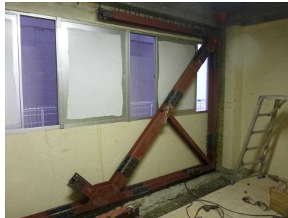
鉄骨ブレース据付け
