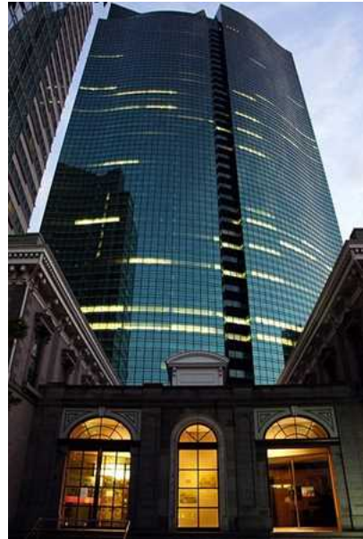
汐留シティーセンターと新橋停車場
