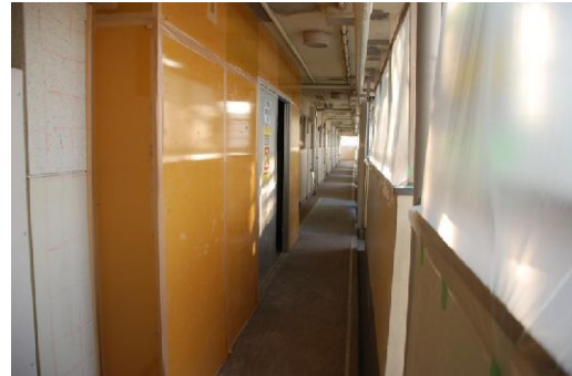
廊下に仮間仕切り壁を設置し、中で工事を実施。
