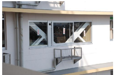
外側から見た住戸内ブレース
