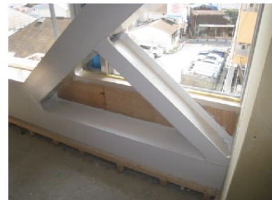
下端の型鋼には蓋がされている
