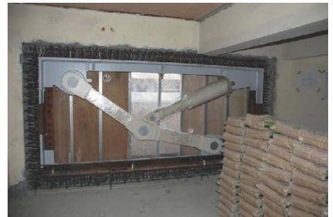
バルコニー側を施工中の住戸。
