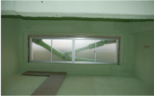
ブレース搬入・組み立てのため、住戸の間仕切り壁が取り払われた住戸。吹付断熱材で覆われて、薄緑色の不思議な空間に。まるでアート。
