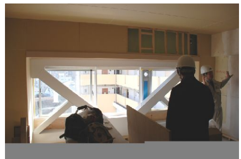
窓一面にとりつけられた室内のブレース
