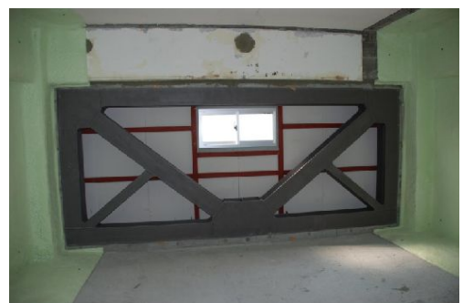
廃止住戸の戸境壁は断熱材吹付けに
