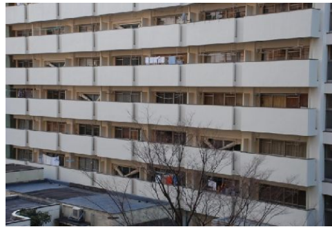
開口部の手前にブレースが見える
