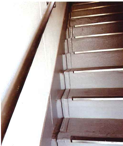
階段踏づら仕上がり状況
