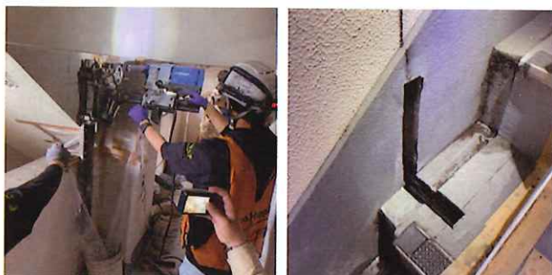
階段側面裏側からの施工状況 突き出たスリット溝 30×70 mm
