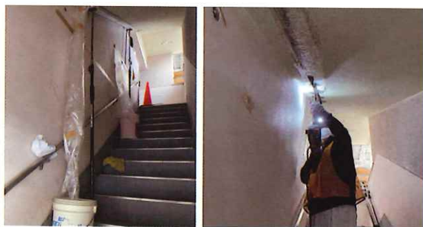
再度製作前の養生状況
