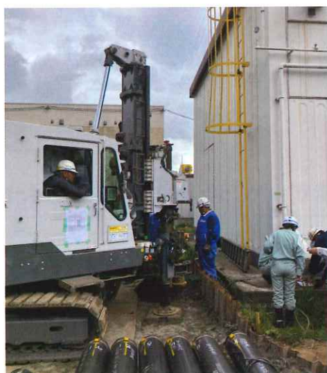
写真2 短尺リーダー機での施工
