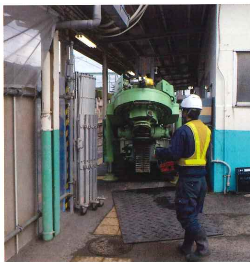
写真3 狭小地における機械搬入
