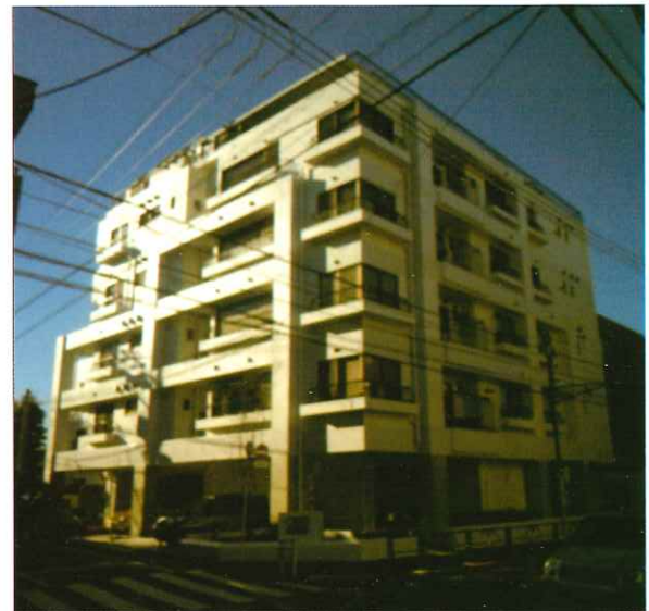
補強後の外観
