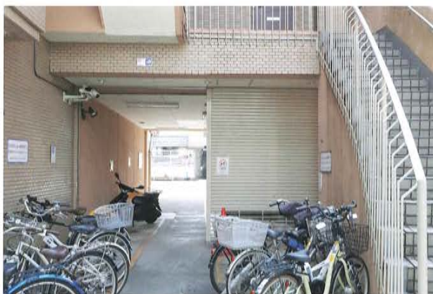
図7 1階ピロティ廻り 開口付耐震壁設置前
