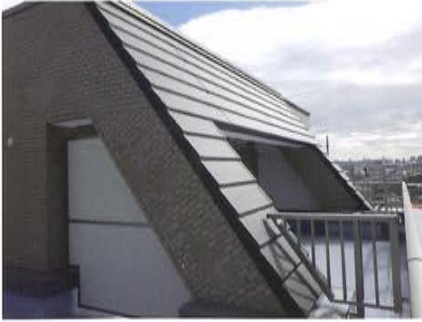
図 17 工事後、ガルバリウム鋼板横葺き
