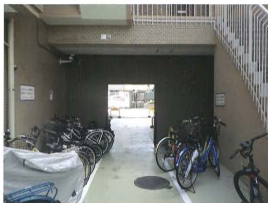
図8 1階ピロティ廻り 開口付耐震壁設置・仕上後
