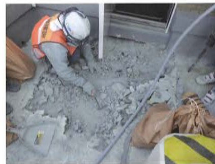
図 21 押えコンクリート層・防水層撤去
