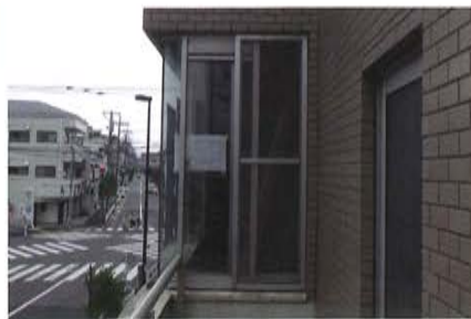
図11 工事前 コーナーサッシ短辺の片引窓
