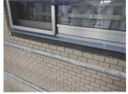
図 15 窓面台の塗布防水、水切金物設置前
