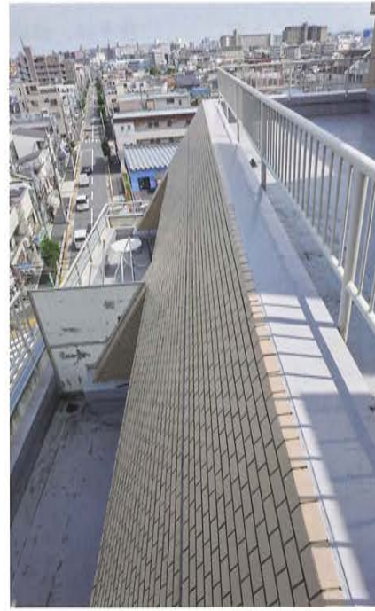
図 18 工事前 天端の納まり、鋼製手摺
