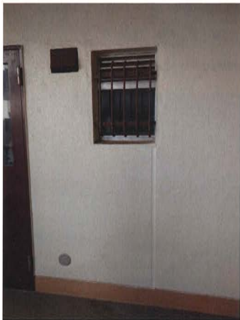
図6 構造スリットの施工後の状況
