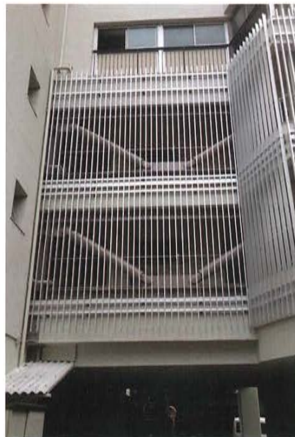
図9 外廊下面に設置されたブレース補強
