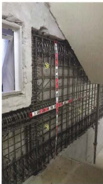
図8 既存の壁を増打補強
