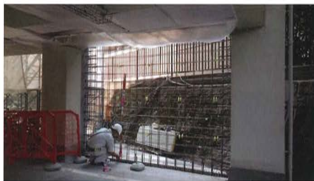
図7 耐震要素として耐力壁を新設
