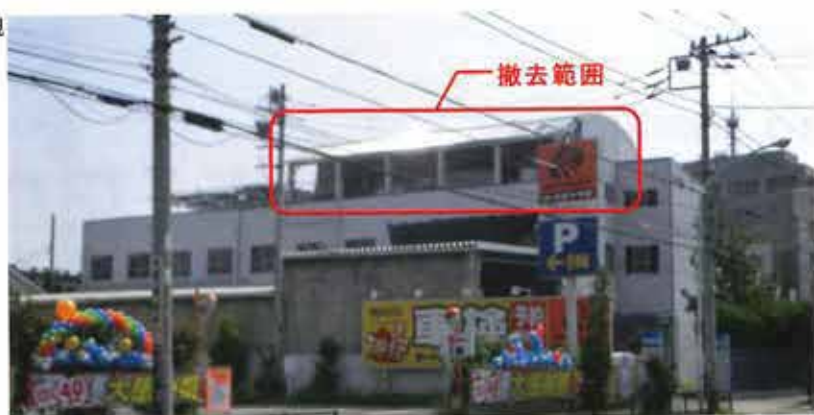
撤去前の南側外観
