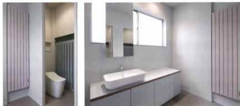
トイレ 便器と洗面台。壁に空調システム設置
