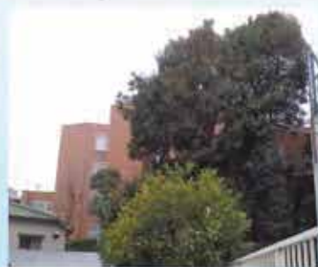
40年以上経過し、建物高さよりも成長した樹木。狭い敷地の中にも多数の樹木が植えられている。
