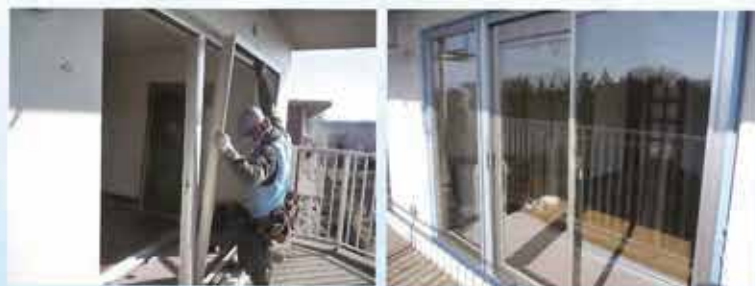
サッシの更新 改修設計・写真提供：IAI・JICオー級建築士事務所
