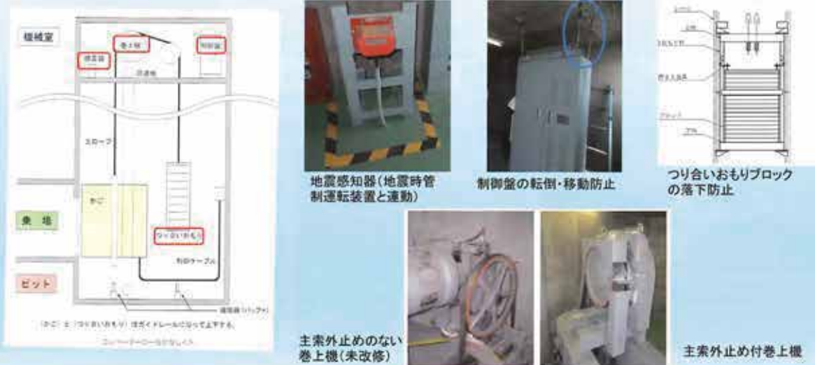
図10 耐震化（エレベーター）
