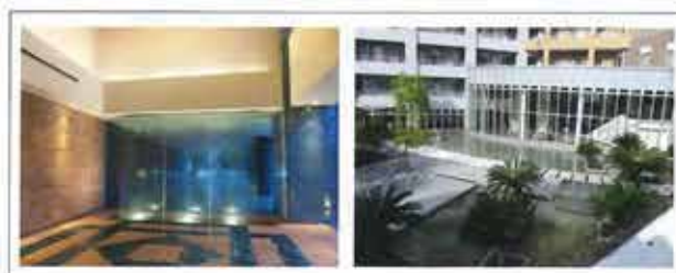
図 21 超高層マンションの修繕対象
