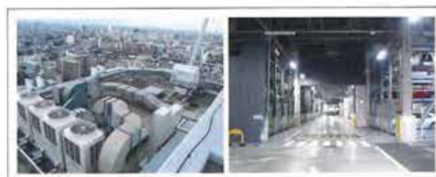
図 27 超高層マンションの修繕対象
