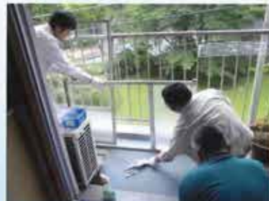
サッシを外して分解清掃
