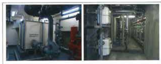
図 25 超高層マンションの修繕対象
