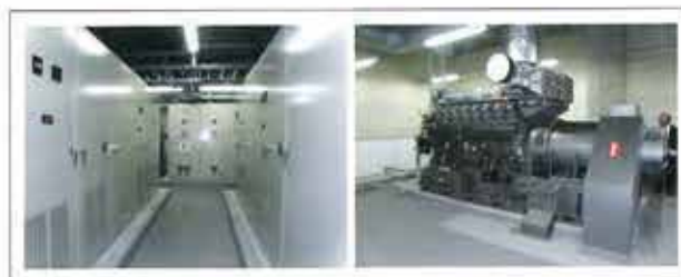
図 26 超高層マンションの修繕対象
