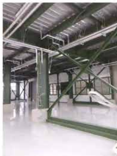
ブレースと柱脚根巻き
