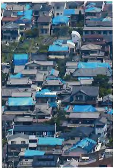
写真1 瓦の被害
