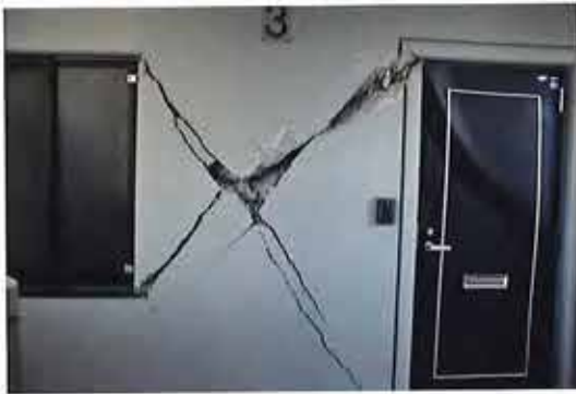
写真9・10 非構造壁の復旧と共に、玄関ドアなど二次部材も更新した。復旧前(左)、復旧後(右)
