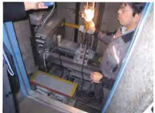
写真6 保守員によるエレベーターの点検
