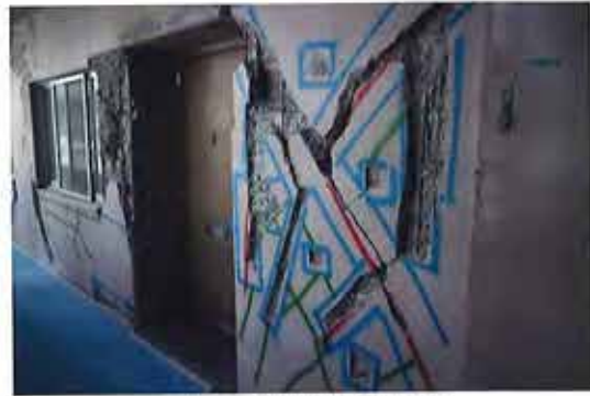
写真8 非構造壁の復旧工事
