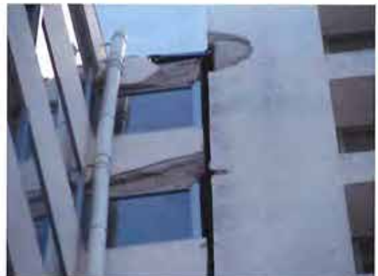
写真4 エキスパンションジョイントの離隔不足による、外壁の破損・剥落
