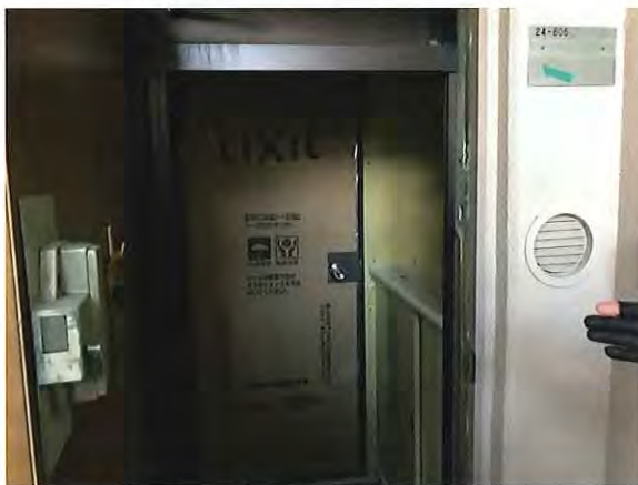
住戸内の廊下に仮設の玄関扉を設けて生活と工事と区画している
