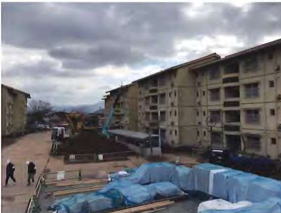
熊本市営A団地全景
