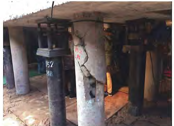
既存PHC(Φ350)の損傷と新規鋼管杭とサポートジャッキ
