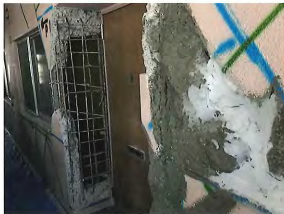
雑壁せん断破壊復旧状況
