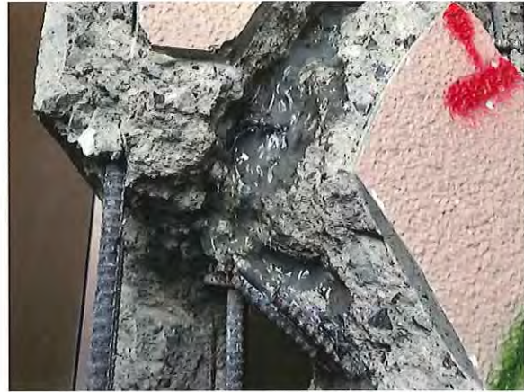
雑壁せん断破壊復旧状況
