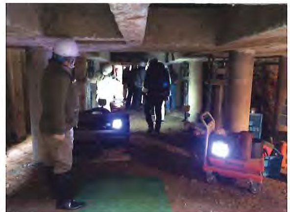
基礎下の掘削された施工空間
