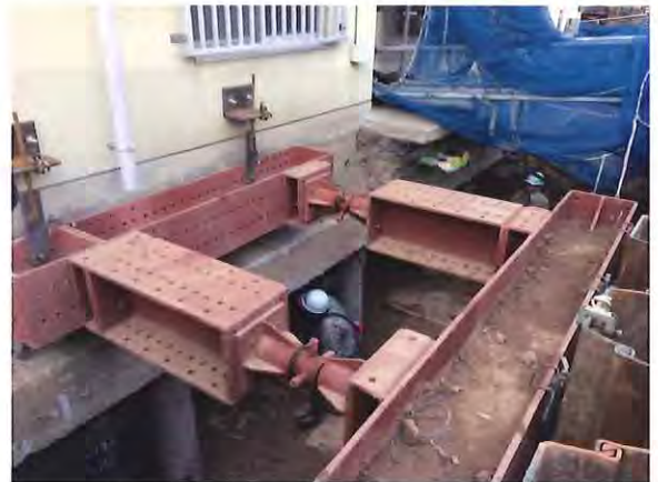
シートパイルによる山留めと切梁
