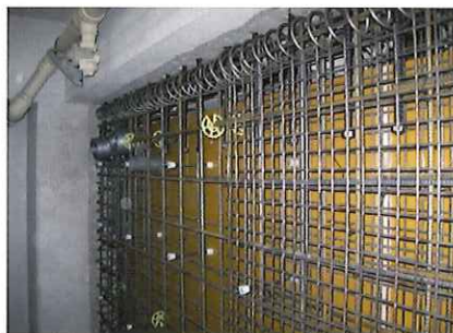
耐震壁増設補強
