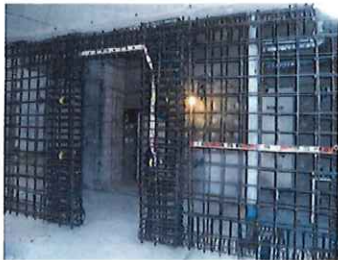
第2・3期補強工事：増設壁補強
