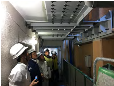
主棟の共用廊下床スラブと副棟の梁と柱を繋ぐ
