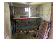
旧受水槽室の壁増し打ち 旧受水槽室に床を張って集会室にコンバージョン
