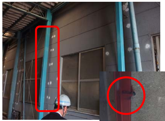
ALC 版脱落防止 上: 白い丸部分はボルト挿入位置 右: 裏側の間柱留め部分
