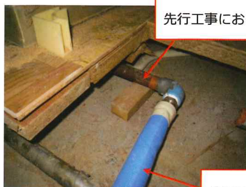
写真 16 専有部分給水管の不十分なリフォーム事例
