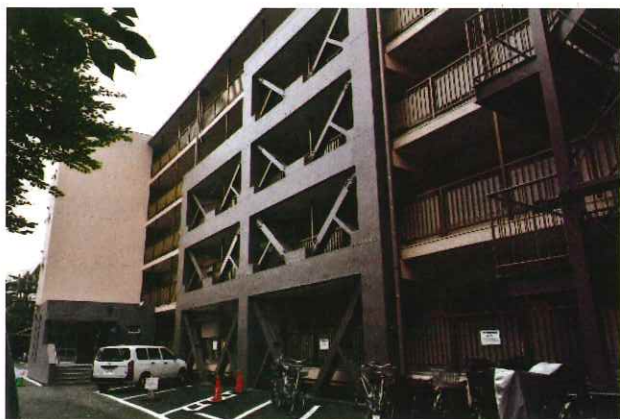
写真1 共用廊下側のブレース架構増設例(1)
