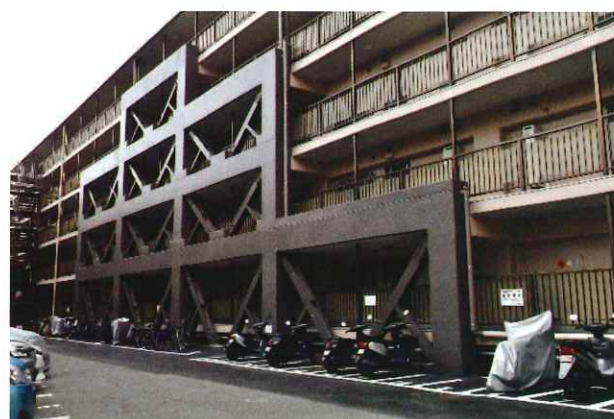
写真2 共用廊下側のブレース架構増設例(2)
