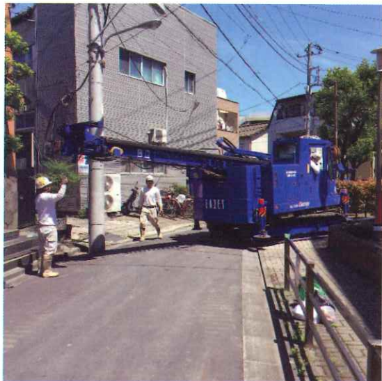
写真5 杭打ち機械 株式会社トーテック 提供
