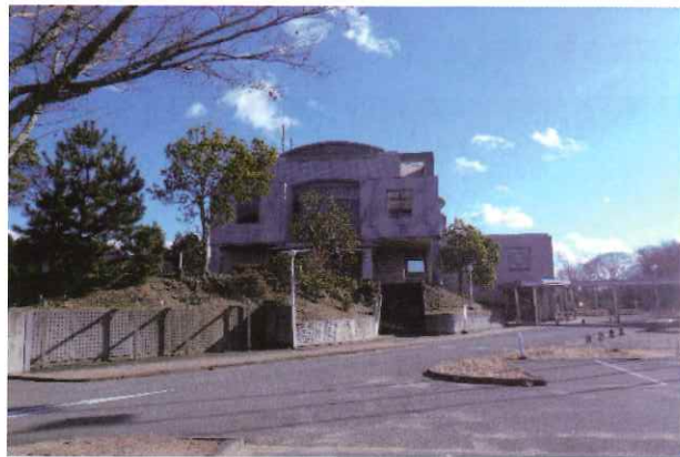
写真9 富岡町役場庁舎
